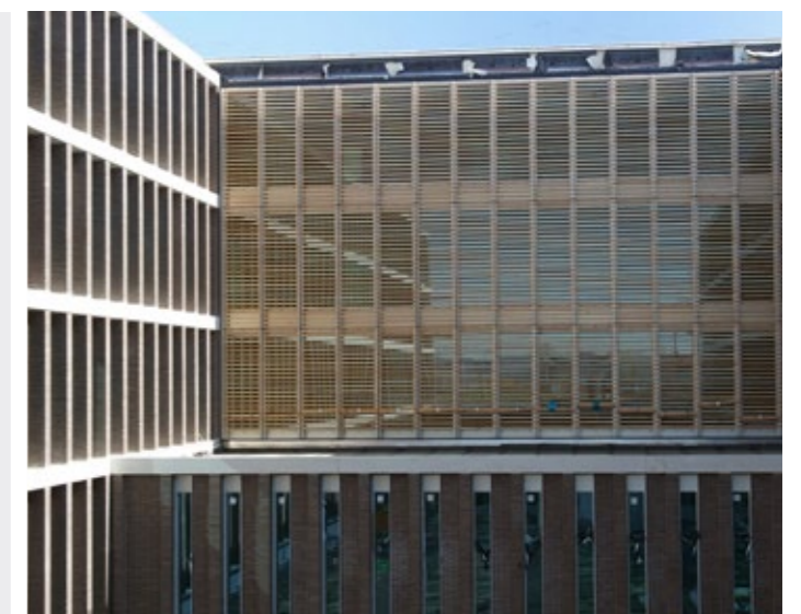
OFD, Münster: Tragende Fassade mit Klinker Verkleidung
