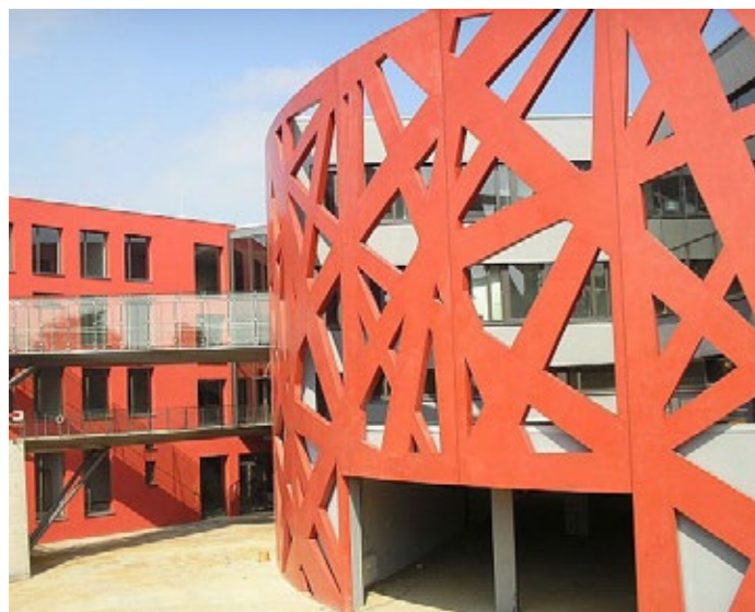
Feuerwache, Köln: roter Sichtbeton, selbstverdichtend
