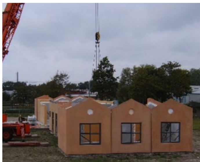
Verpleeghuis, Zuyder Waert: Sandwichfassade, oranger Sichtbeton
