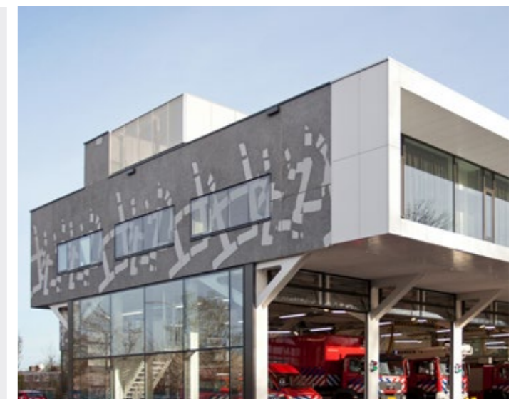
Feuerwache, Leerwarden: Tragende Fassade, gestrahlt
