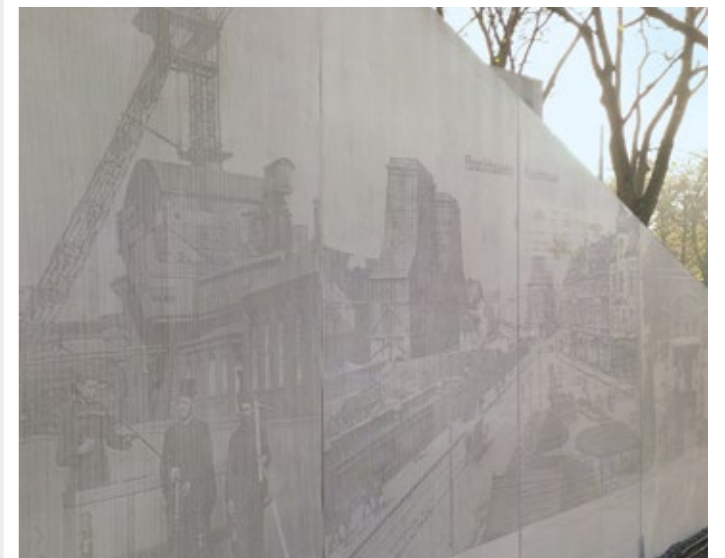
Landschaftsbauwerk „Grüngürtel“, Duisburg: Sichtbeton mit Fotomatrizen
