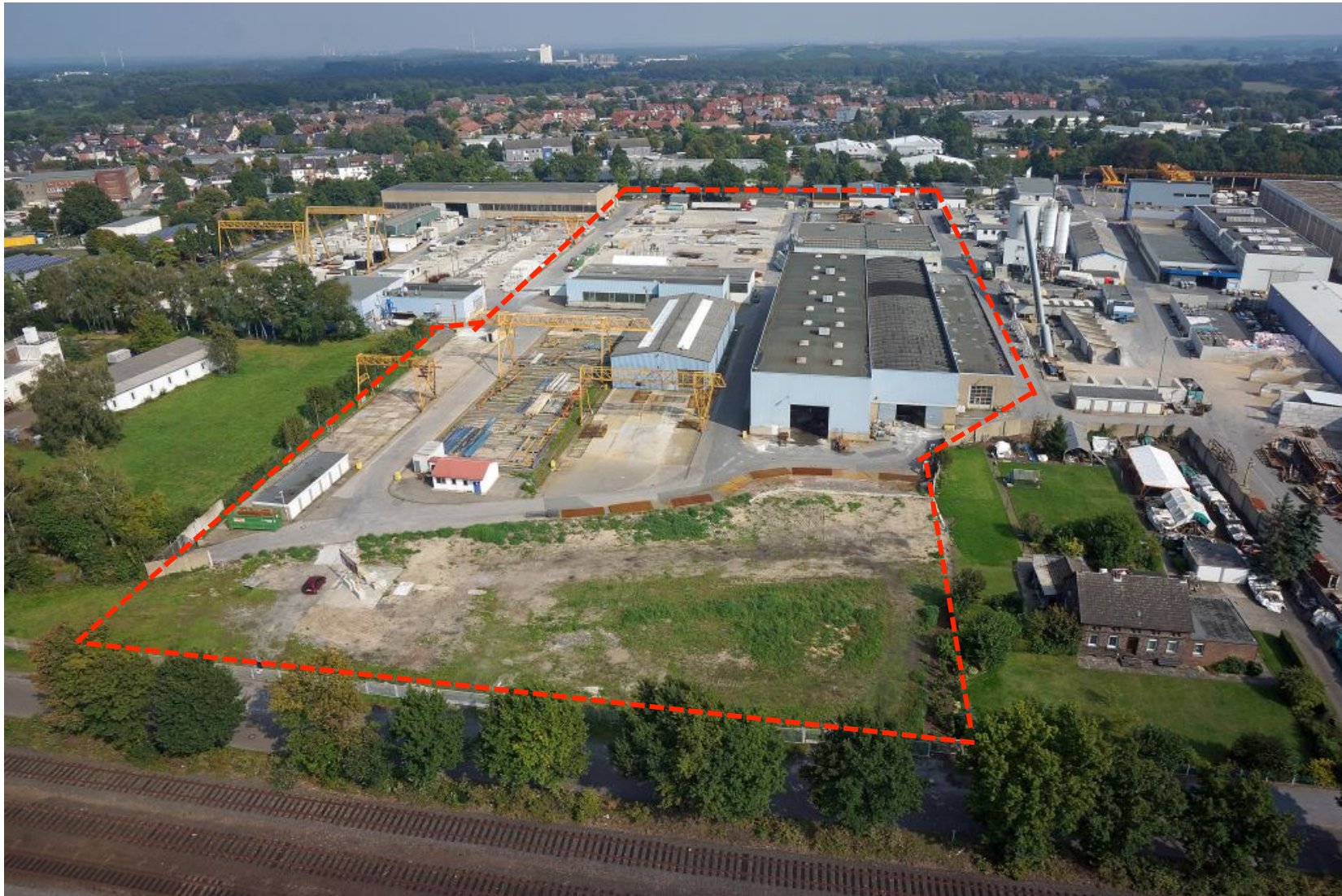
Luftbild befestigte Fläche (33.280 qm) mit Bestand, Schienennähe, Ansicht Gelsenkirchener Str.
