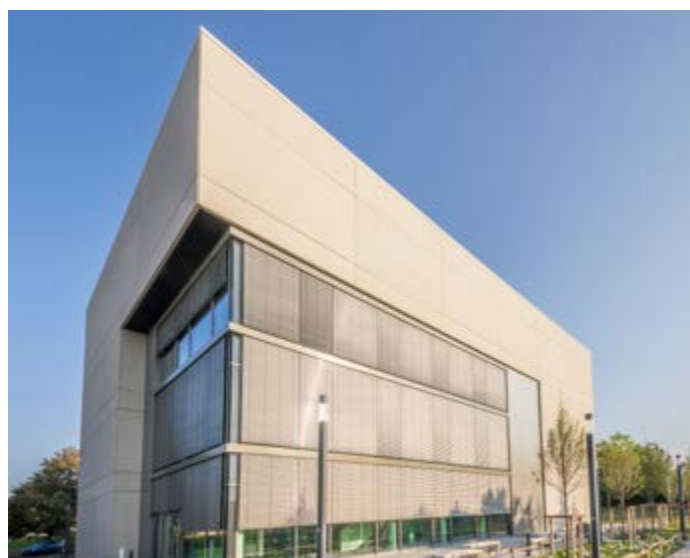
Uni Gießen, Architekturbetonfassade – Sichtbeton, gelb fein gestrahlt
