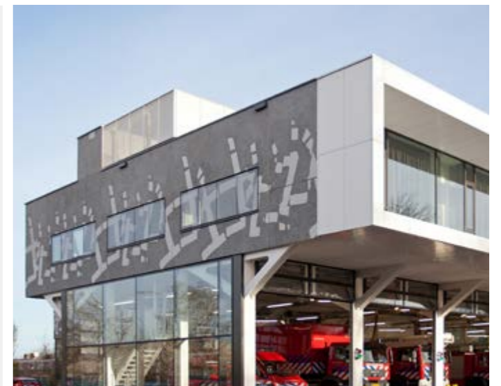
Feuerwache, Leerwarden: Tragende Fassade, gestrahlt
