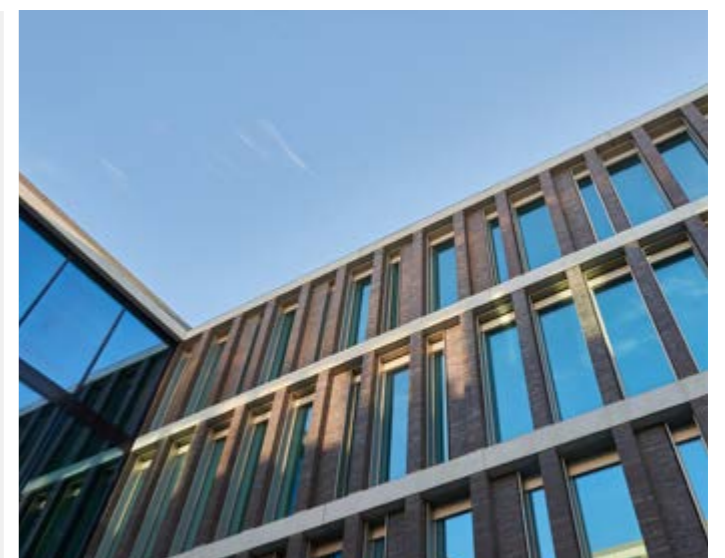
OFD, Münster: Tragende Fassade mit Klinker Verkleidung
