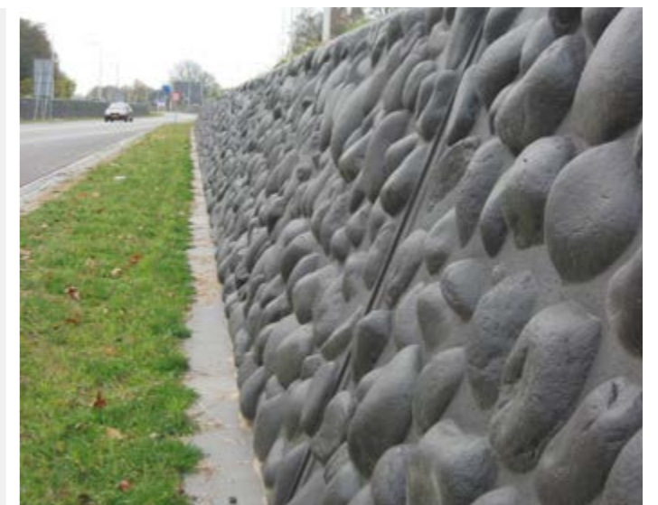
Stützwand Alverna: grauer Sichtbeton, Findlingoptik
