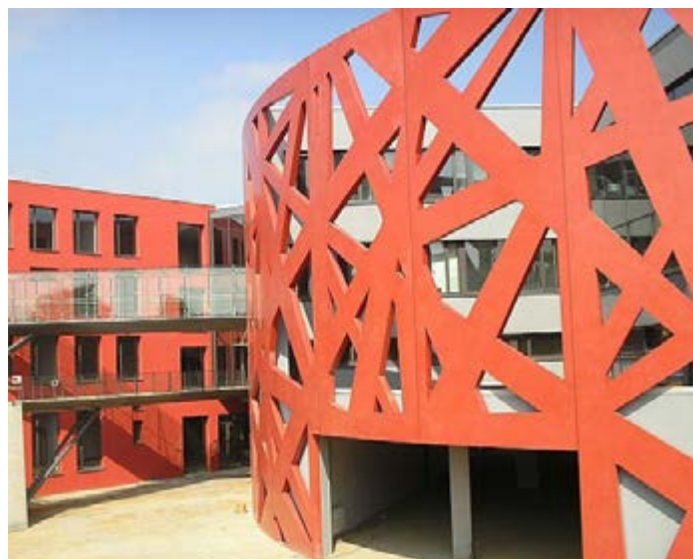
Feuerwache, Köln: roter Sichtbeton, selbstverdichtend
