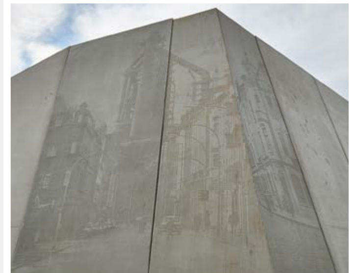
Landschaftsbauwerk „Grüngürtel“, Duisburg: Sichtbeton mit Fotomatrizen
